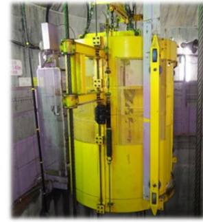
ひと こうじよう 人キブル(工事用エレベーター)
